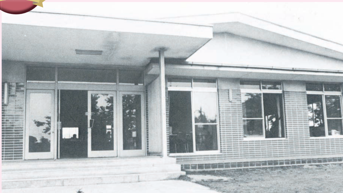
カレッジセンター完成。軽演劇、会議室、パーティなど当時は多目的ホールとして利用された。現在(昭和60年当時)は食堂の一部として利用されている。
